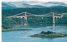
el puente bridge
